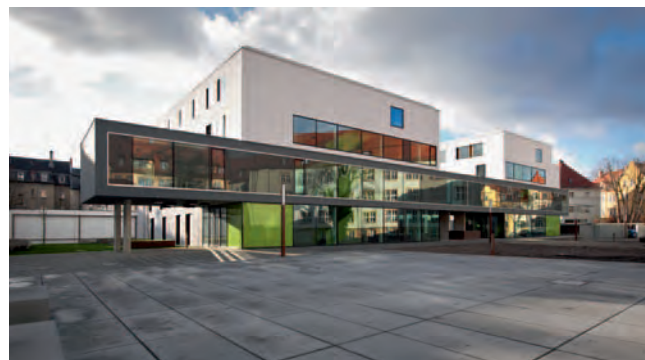
29 Universität Bamberg – Hörsaal- und Verwaltungsgebäude (ARGE Gatz, Bamberg und Kuntz + Manz, Würzburg)
