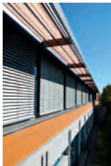
25 Fachhochschule Würzburg-Schweinfurt, grundlegende Sanierung des Campus in Schweinfurt
