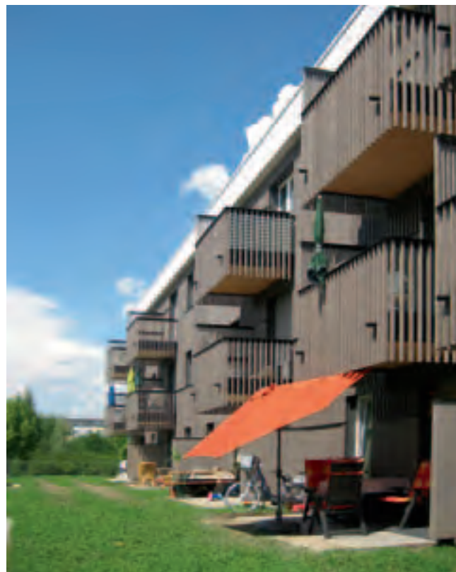
Modellprojekt in Ingolstadt: Unterschreitung der Anforderungen der EnEV um mehr als 50%, sehr hoher solarer Deckungsgrad und CO 2 -neutraler Baustoff Holz (bogevischs buero, München)
