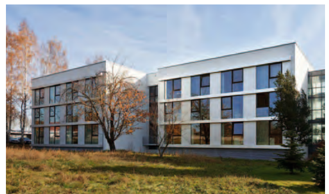
Gesundheitsamt Fürstzell vor und nach der Sanierung (Walter Schwetz Architekt BDA, Passau)
