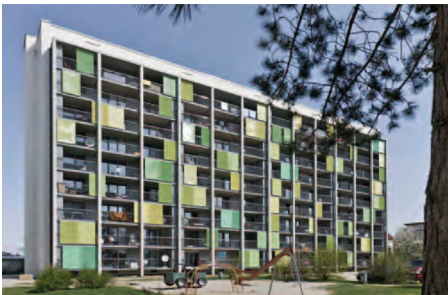
35 Modernisierung Dörflerstraße Ingolstadt (Ebe + Ebe + Partner, München)
