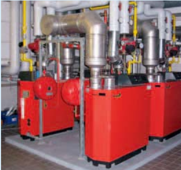
Heizungszentrale mit Gas-Brennwertkessel
