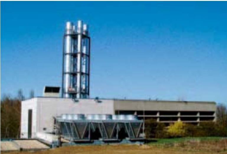
Technische Zentrale der Universität Regensburg
