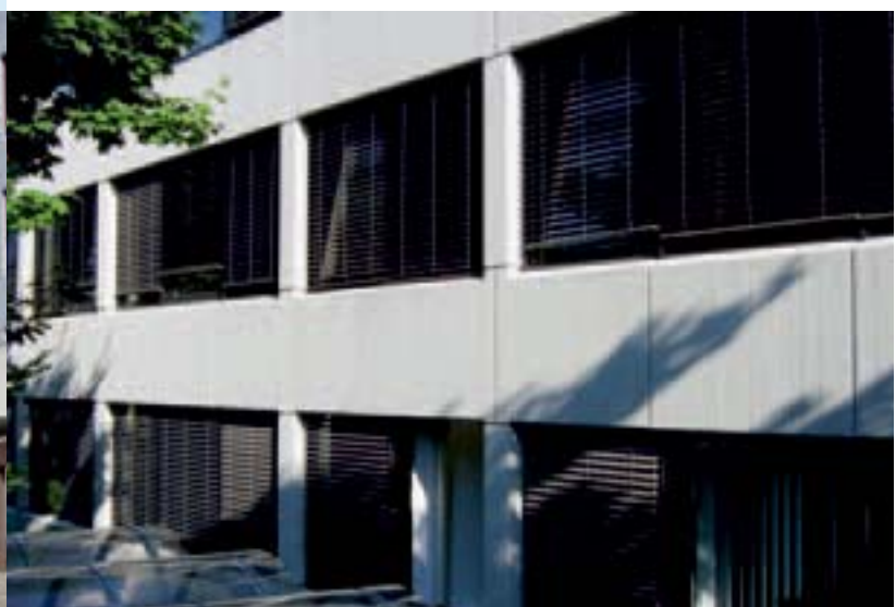
Fassadendetail Ämtergebäude Bayreuth
