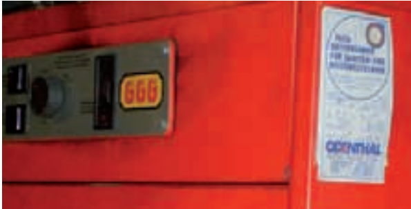
Bild 5.1.9-4: Gasbetriebener direkt beheizter Trinkwarmwasserspeicher
