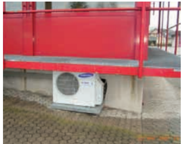
Bild 5.1.8-9: Splitgerät Außeneinheit (Verflüssiger und Verdichter)
