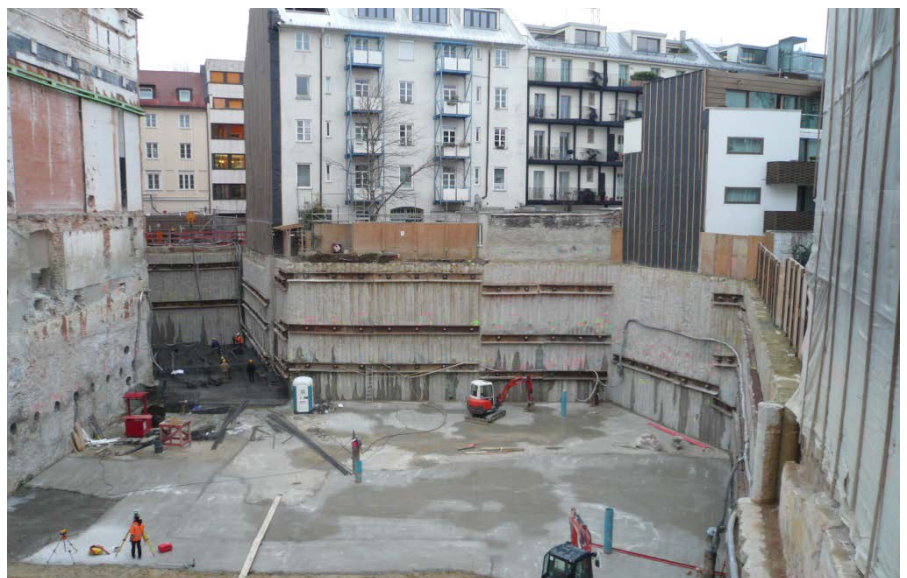
Baugruben-Verbau, links Bühnenturm, hinten und rechts Nachbarhäuser (© StBA M1)
