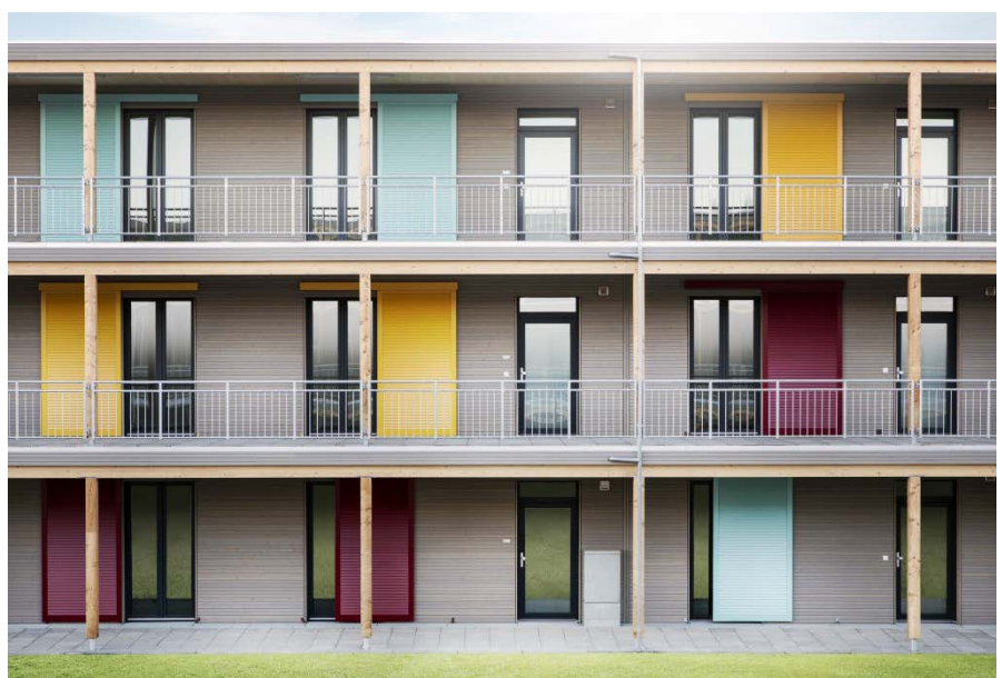
Ansicht Laubengang (© Bauer Holzbausysteme GmbH & Co.KG)
