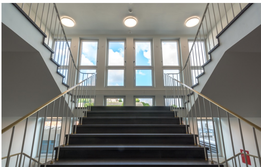
Denkmalgeschütztes Haupttreppenhaus (© Thomas Gura StBA Wü)
