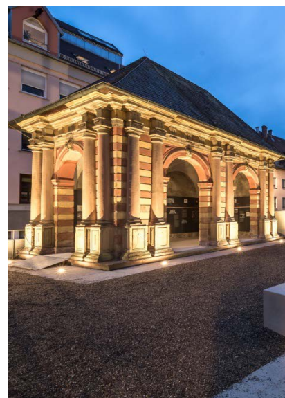
Bereich Pavillon (© Thomas Gura StBA Wü)
