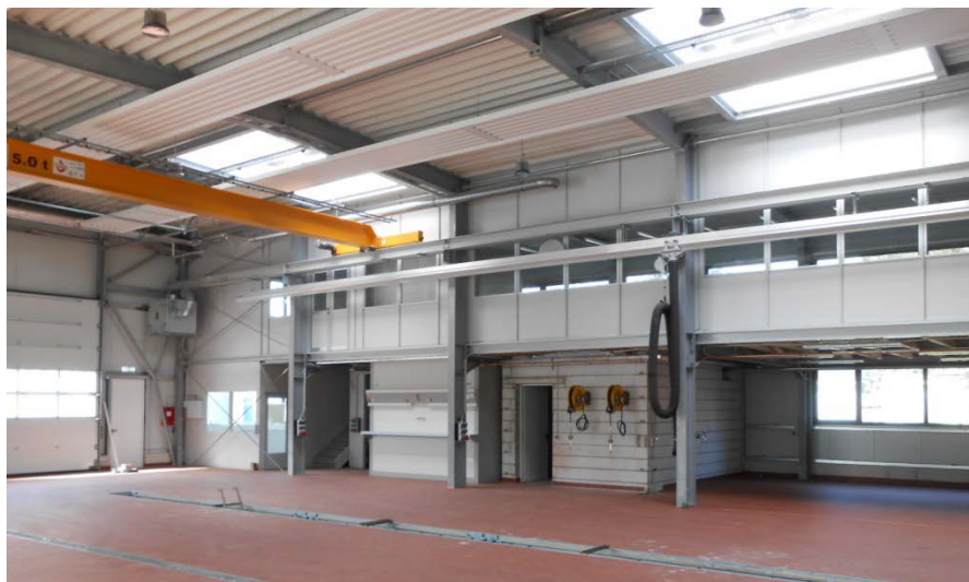
Werkhalle Innenansicht (Foto © StBA AB)
