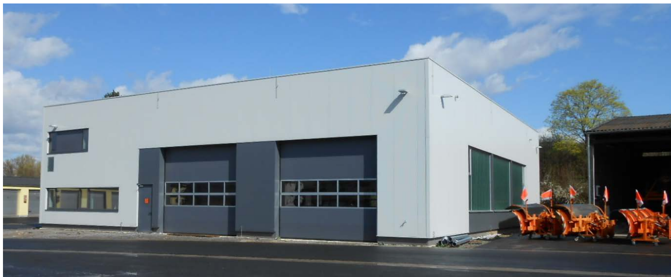
Neue Werkhalle Straßenmeisterei Mainaschaff (Foto © StBA AB)
