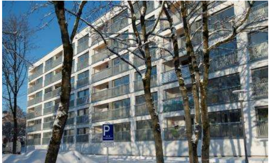
Süd-Ost-Ansicht mit vorgehängter Fassade (Foto: Dörthe Hagenguth, Hamburg)
