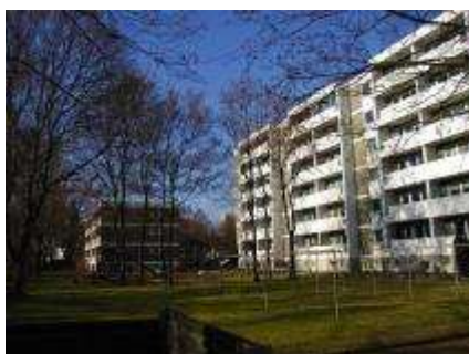
Wohngebäude vor der Modernisierung (Foto: WBG Augsburg)
