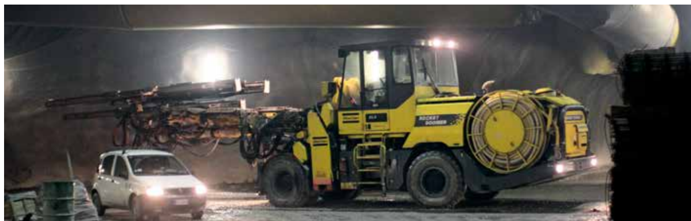
Macchinario di cantiere in movimento
