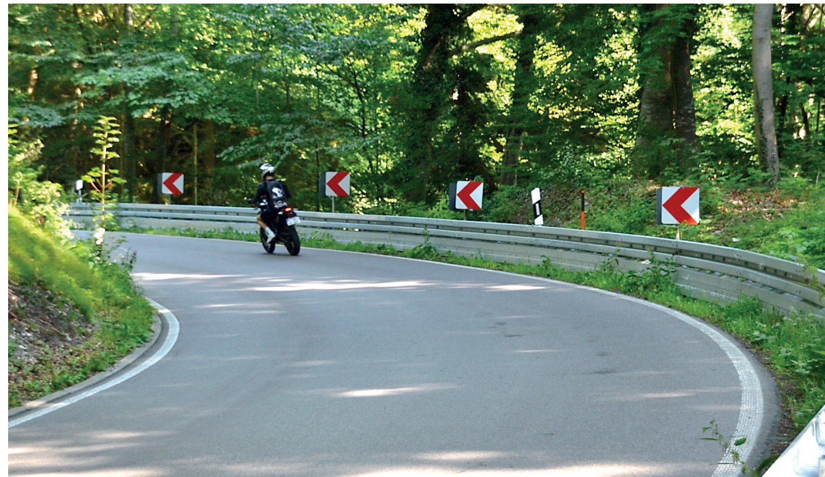
Abb. 27 Beispiel einer schlecht einseharen Kurve mit aufgelösten Richtungstafeln, Schutzplanke und Unterfahrschutz
